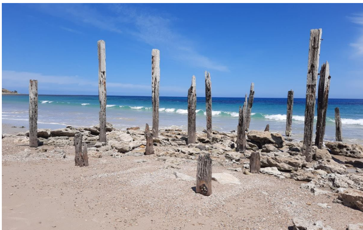
Old Port Willunga Jetty pylons, Port Willunga (GGA, 2022)
